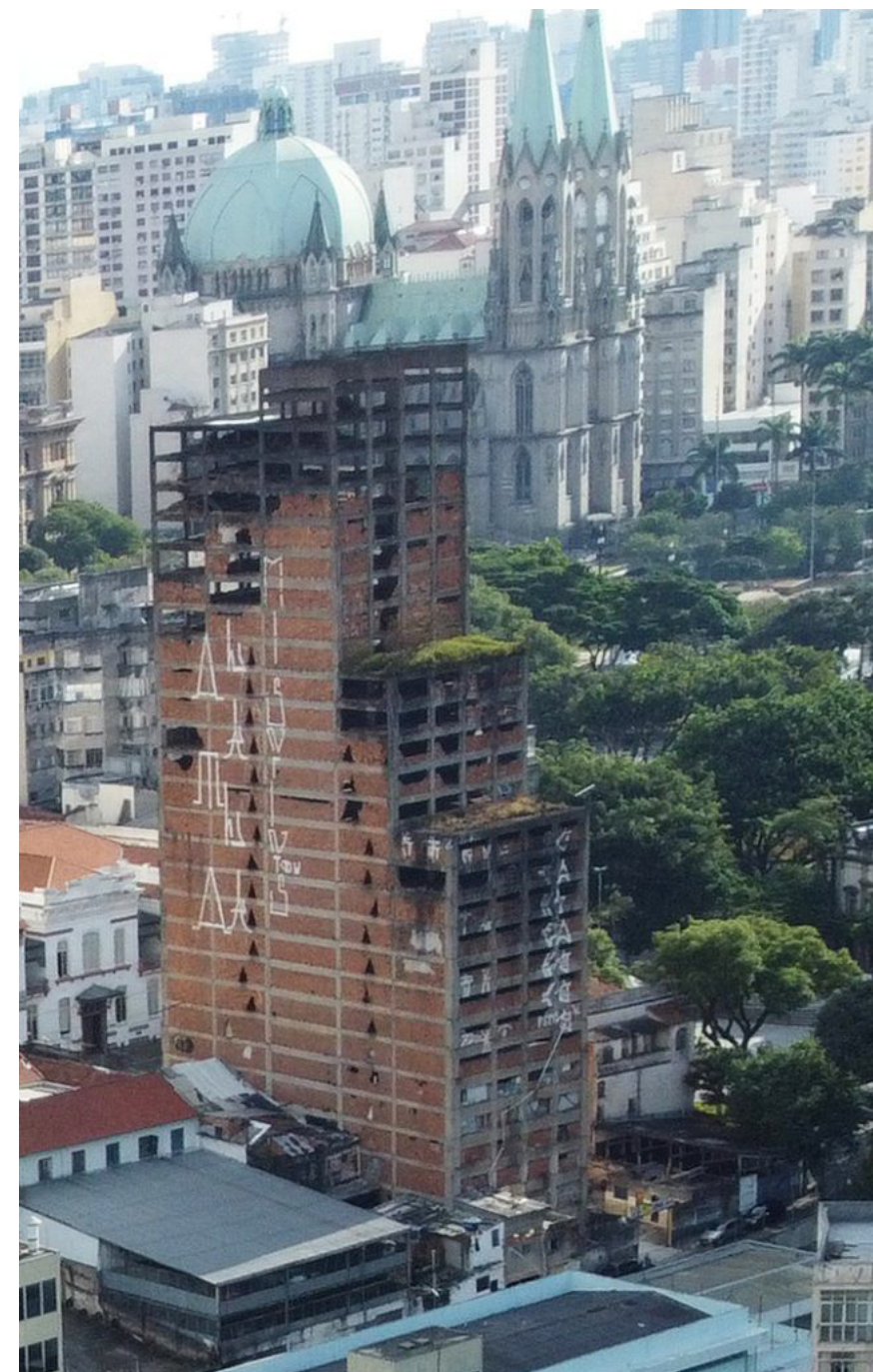
Edifício garagem abandonado na Rua do Carmo, próximo à Catedral. Autor desconhecido. Disponível em: https://saopauloantiga.com.br/edificio-rua-do-carmo-93/
